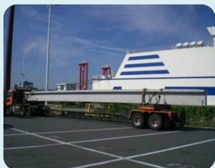
橋桁輸送 (ポルトトレーラー) ＜フェリー輸送＞
