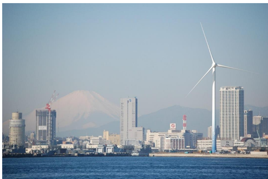
横浜市風力発電所（ハマウイング）
