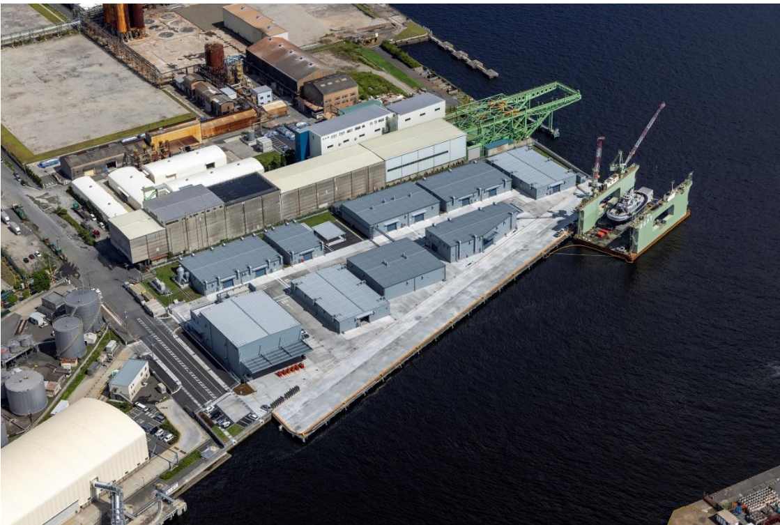
【神奈川埠頭倉庫営業所の外観】
