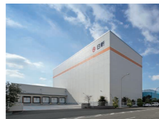
摩耶西冷蔵倉庫
