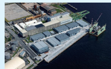
神奈川埠頭倉庫
