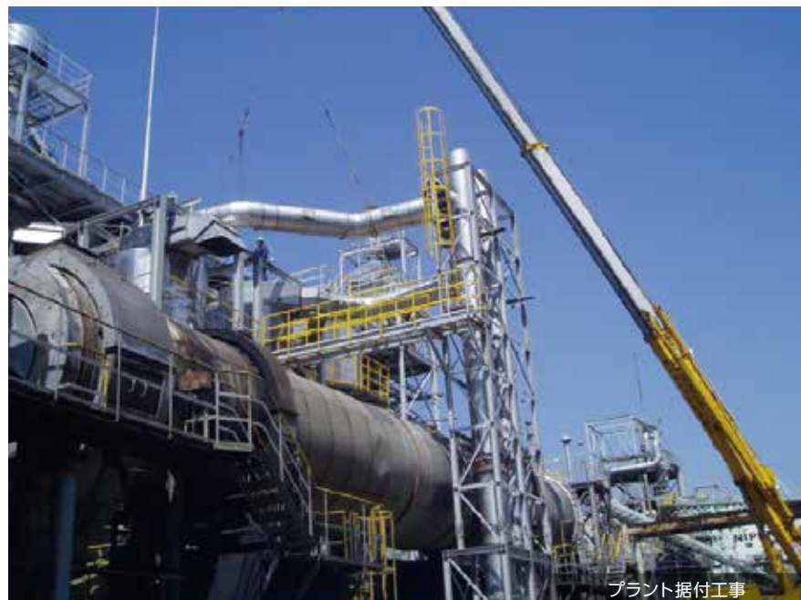
プラント据付工事
