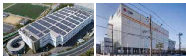
太陽光発電設備 （堺ロジスティクスセンター） 再エネ電力への転換 （平和島冷蔵物流センター）
