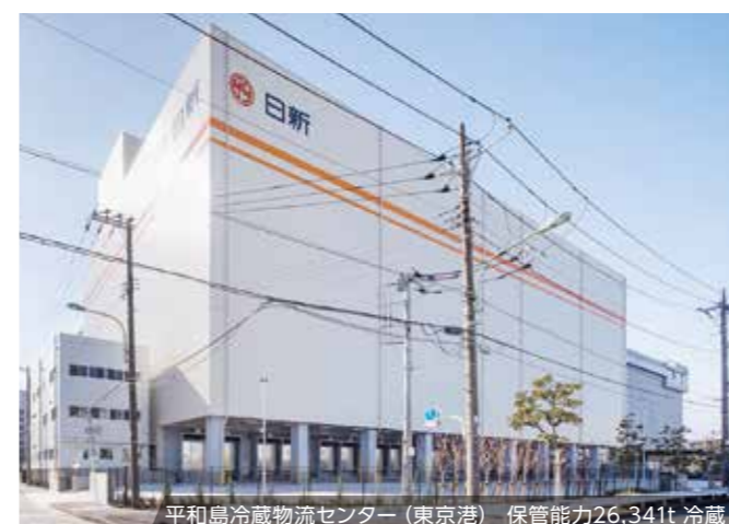
平和島冷蔵物流センター（東京港） 保管能力26,341t 冷蔵
