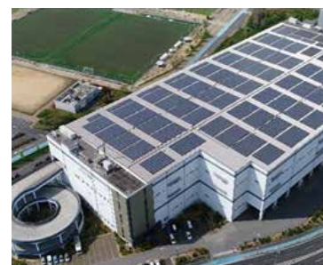
太陽光発電設備 (堺口ジスティクスセンター)
