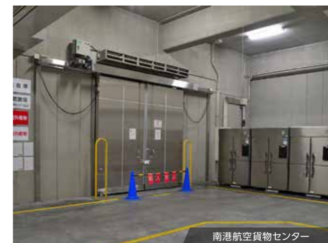
南港航空貨物センター
