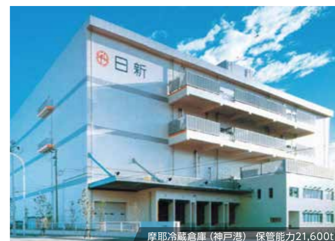
摩耶冷蔵倉庫（神戸港） 保管能力21,600t
