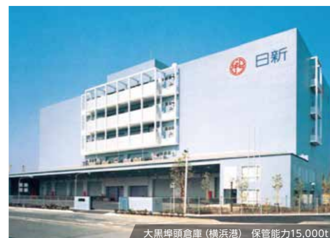
大黒埠頭倉庫（横浜港） 保管能力15,000t
